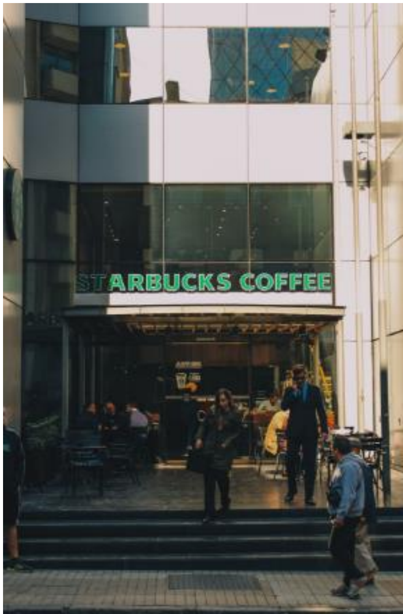
Figura 4. Inmueble ubicado en calle Agustinas 632
